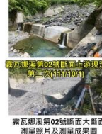
霧瓦娜溪第02號断面大断面測量照片及測量成果圖
