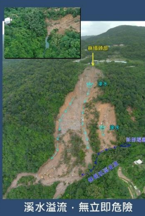
現況調查-頭部地表已多開裂下陷
