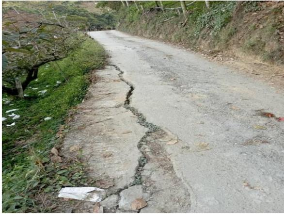
有一泥土路段的靠外邊坡側出現和道路方向平行的長裂縫
