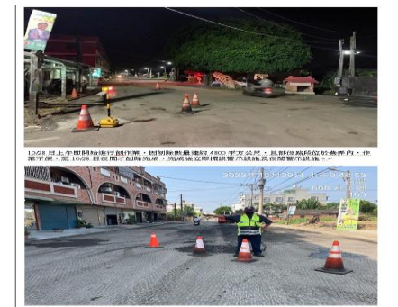
10 / 29 上午進行瀝青混凝土鋪設作業現場均有擺設警示設施及配置人員進行交管工作
