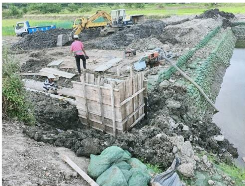
出水口放流井施工中預計 109 年 8 月 30 日澆置完成
