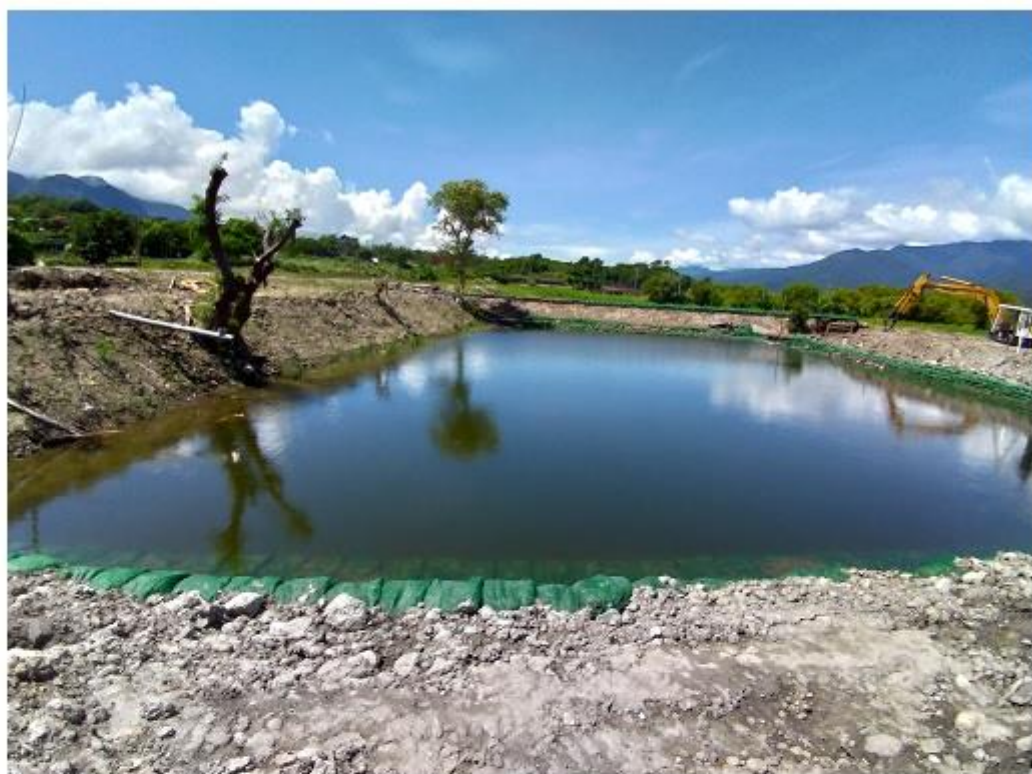
出水口放流井施工前農塘現況
