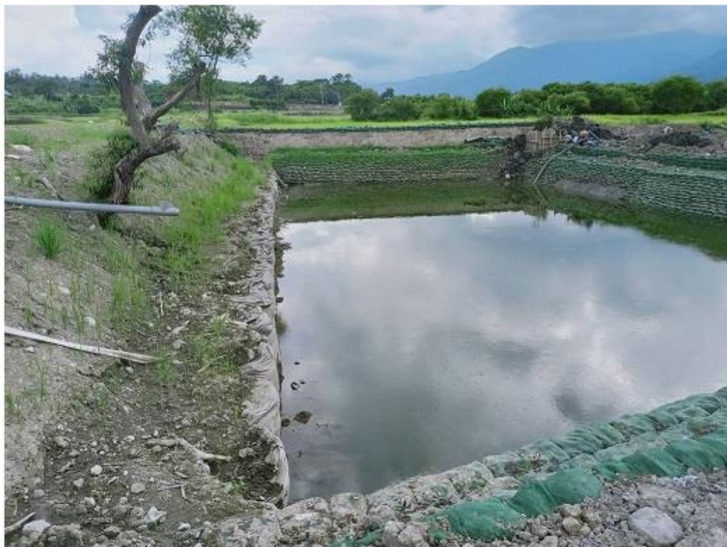
出水口放流井施工現有農塘水位
