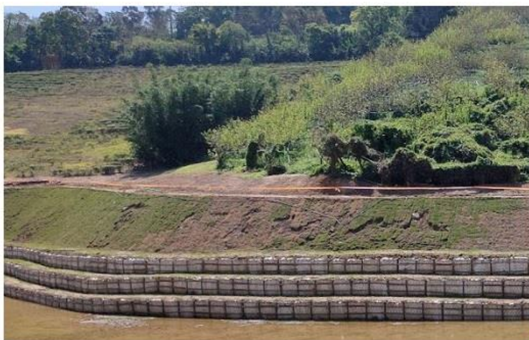
施工後 0K+060 左側邊坡，依原地形坡面設置未開挖坡腳(拍攝日期 109/03/16)
