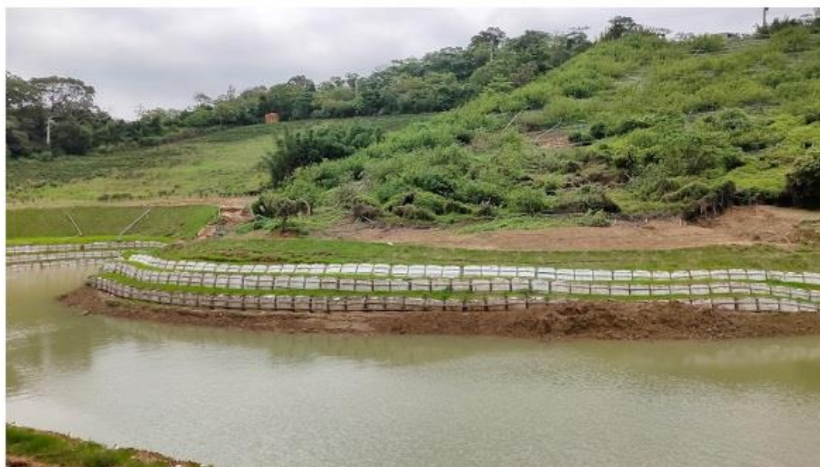
0K+060 堤岸上邊坡崩塌，造成護岸向池內推擠變形(拍攝日期 109/4/3)
