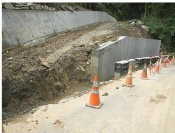
橫向排水施作位置，已開挖造成道路中斷
