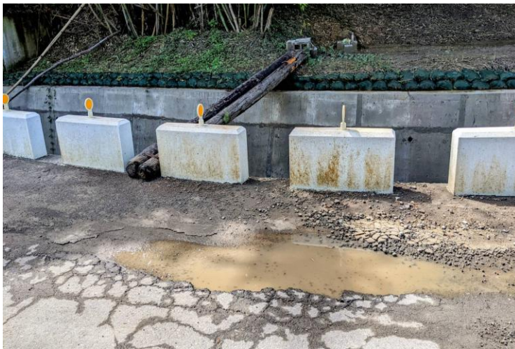
水泥破碎 有小碎石 回填路面下陷
