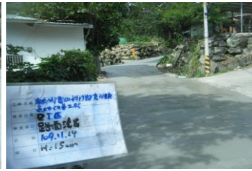
當日施工現場照片
