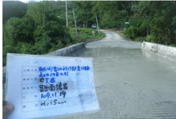
當日施工現場照片
