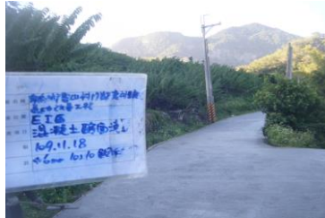
當日施工現場照片
