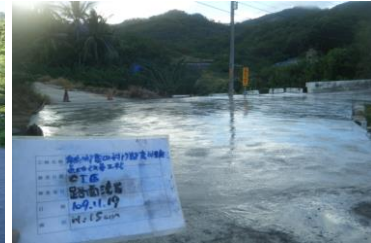
當日施工現場照片
