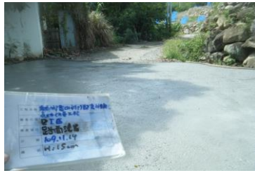
當日施工現場照片
