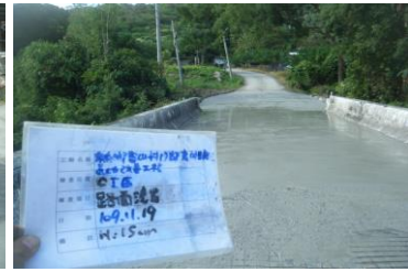
當日施工現場照片
