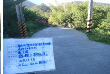
當日施工現場照片
