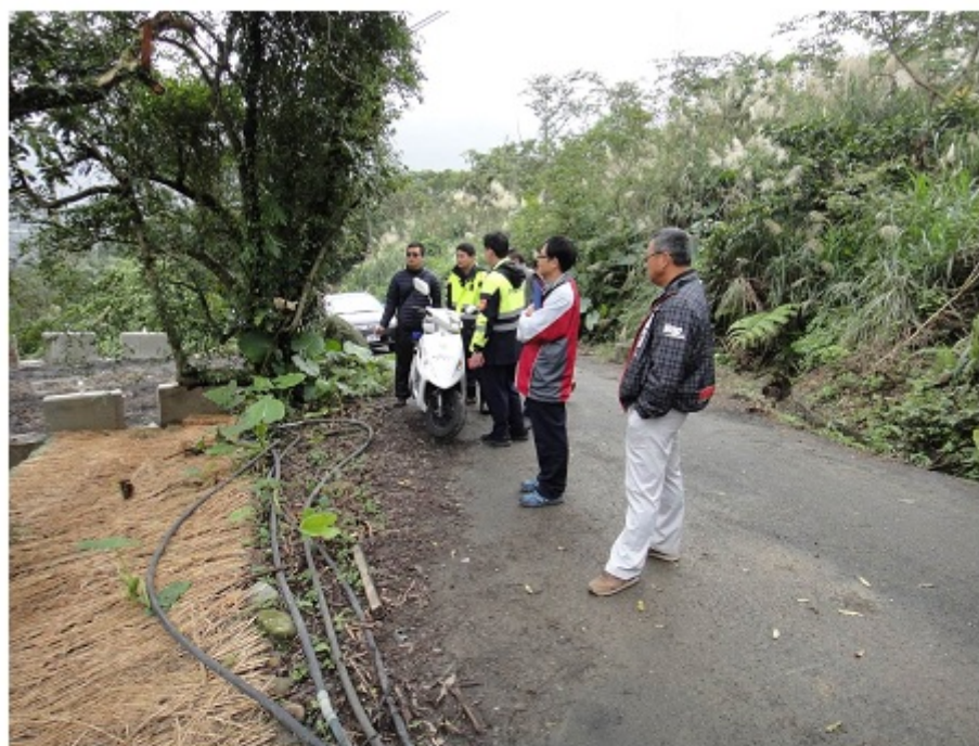
現場會勘情況
