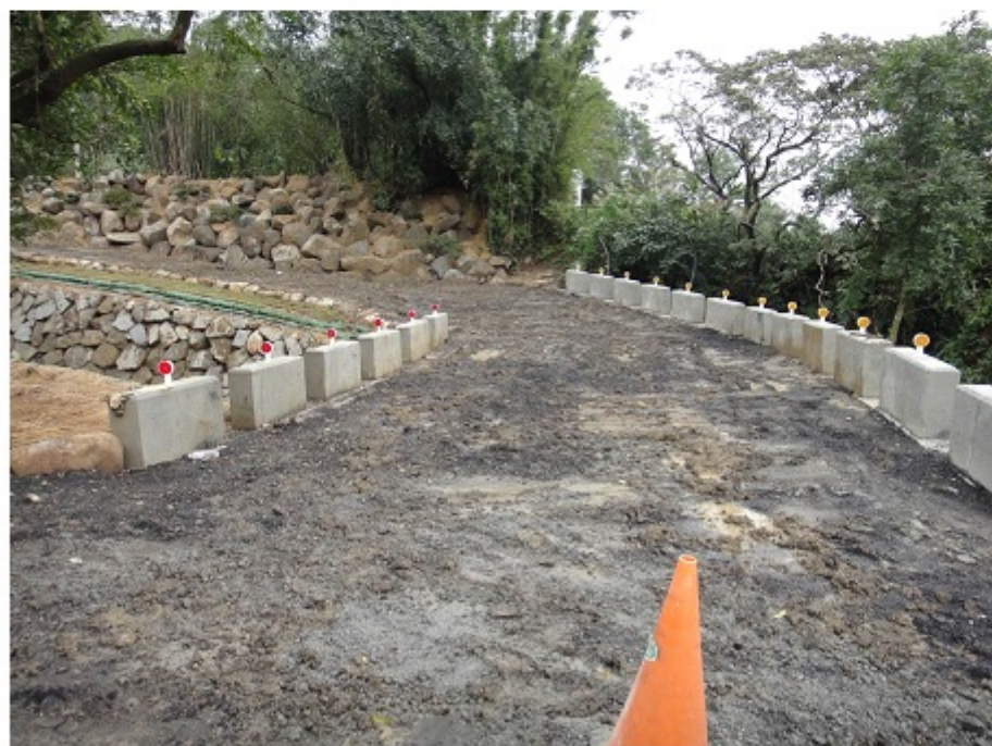
現場會勘情況
