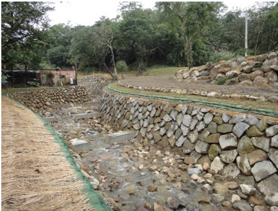
現場會勘情況
