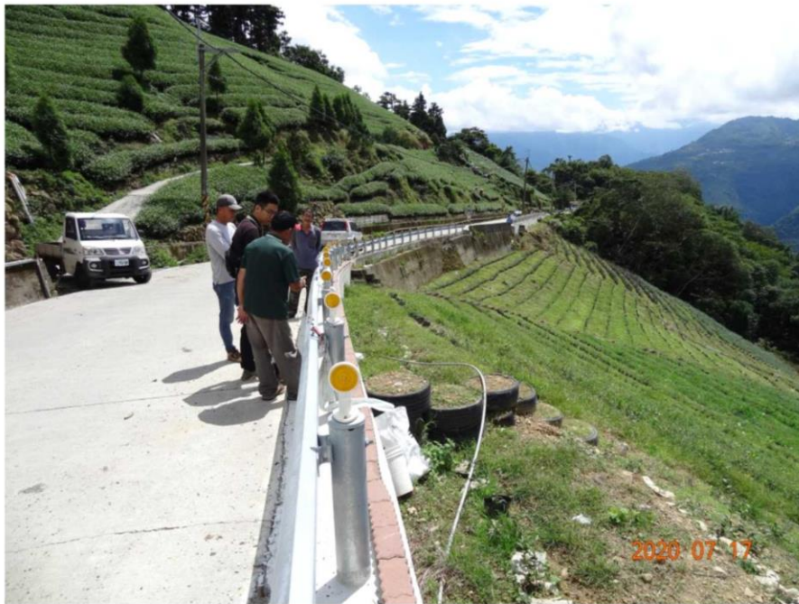
照片(2) 工區 0k+740 處既有工作道，承攬廠商施工時尚未預留出入缺口。
