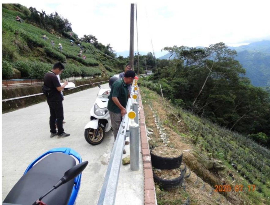
照片(3) 工區 0k+672 處既有工作道，承攬廠商施工時尚未預留出入缺口。
