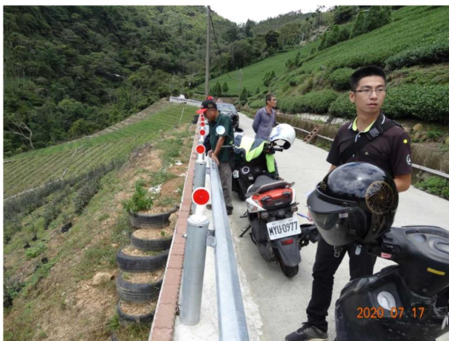
照片(4) 工區 0k+640 處既有工作道，承攬廠商施工時尚未預留出入缺口。
