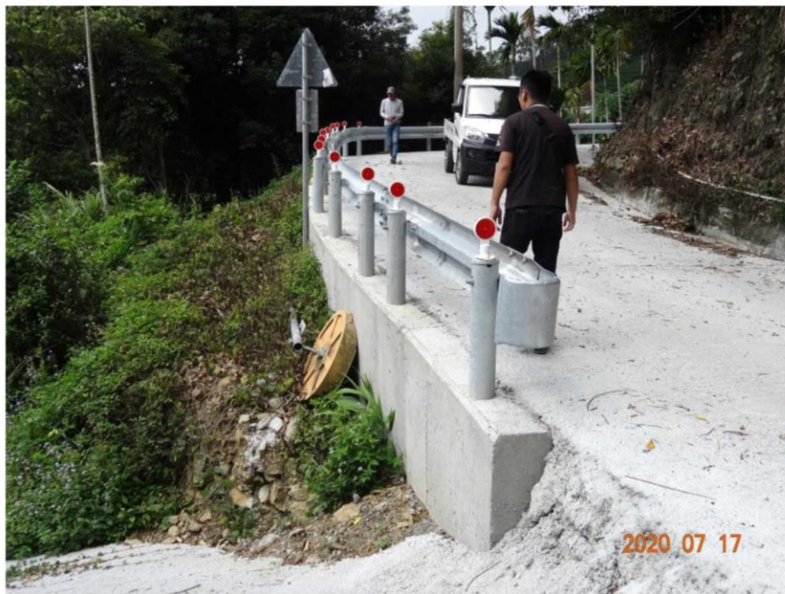
照片(7) 工區沿線既有反射鏡，承攬廠商於施工中拆除丟棄路旁。
